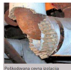
Poškodovana cevna izolacija
